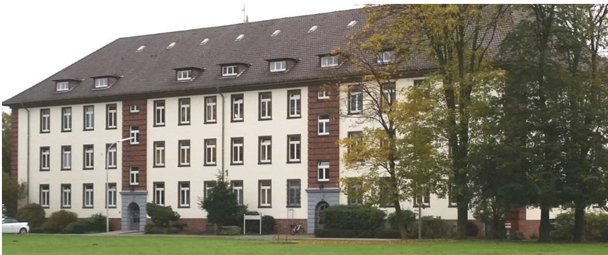
Foto oben Alte Artillerie: Relief am Wirtschaftsgebäude der Scharnhorst-Kaserne 2.
